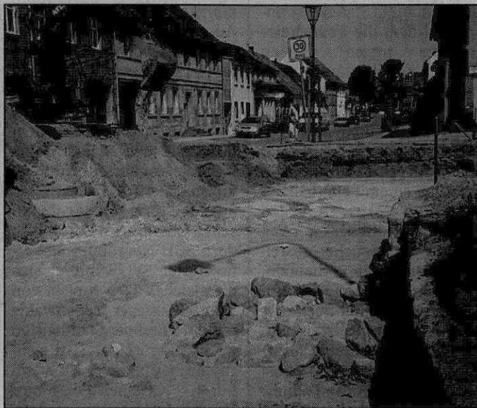
Unter der Breiten Straße tauchte ein Brunnen auf. Noch bis in die 50er-Jahre hinein soll er sichtbar gewesen sein. FOTO: TREICHEL
