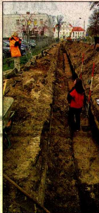
Graben, vermessen, kartieren – Archäologen und Baufirma arbeiten Hand in Hand.
