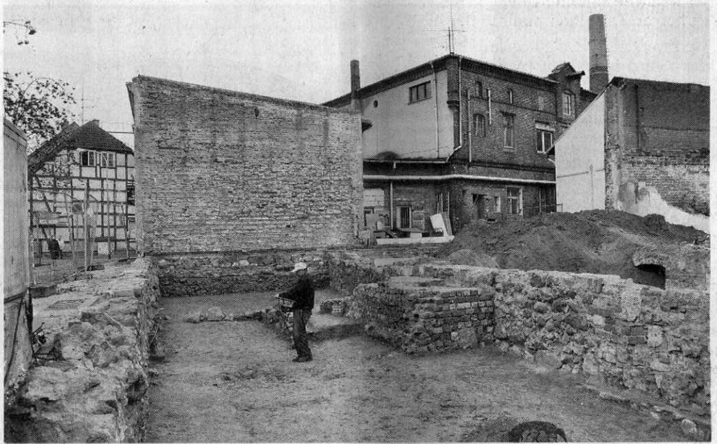
Entlang des Baugrubenrandes im Hintergrund verlief einst die Stadtmauer.
