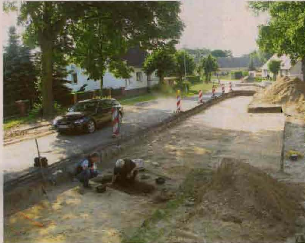
Das bis Montagabend freigelegte Gräberfeld entlang der Glambecker Dorfstraße ist etwa 60 Meter lang.
