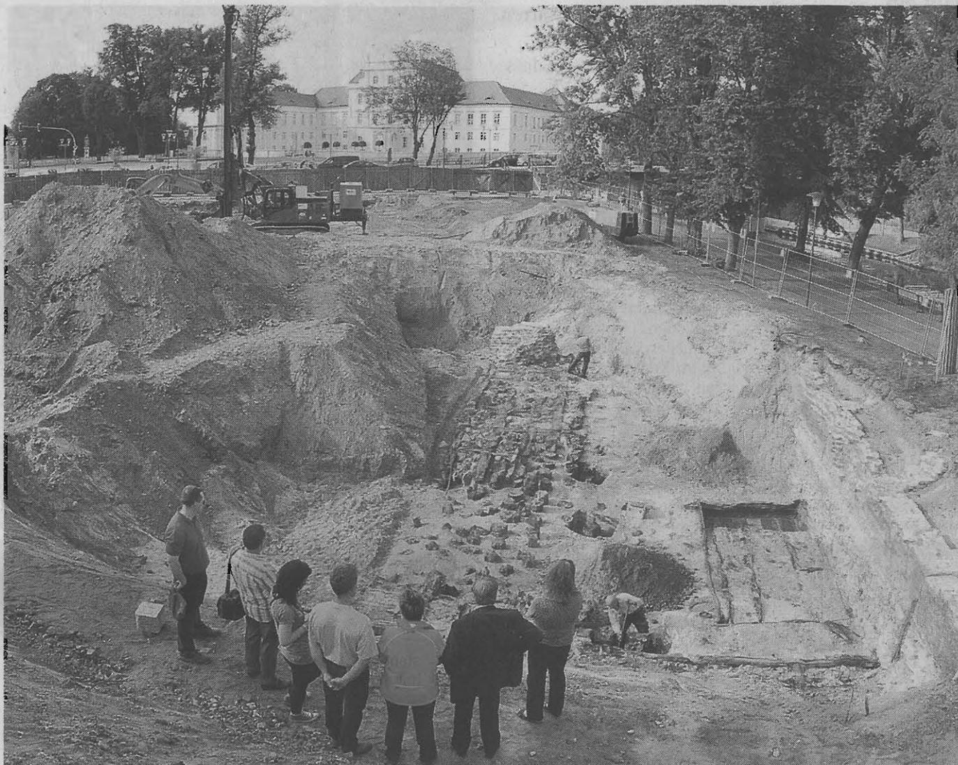
Das Fundament des Wasserturms mit einer Grundfläche von 24 mal 24 Metern ruhte auf Dutzenden Kiefernholzpfählen. FOTOS: ENRICO KUGLER
