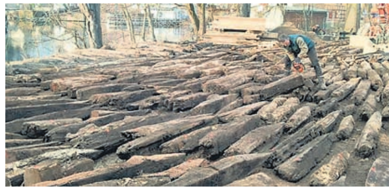
Proben von hölzernen Bauteilen am Mühlengraben und am Umfluterbereich bei den Arbeiten am Wehr. FOTO: BAB HAUPTMANN + BACH
