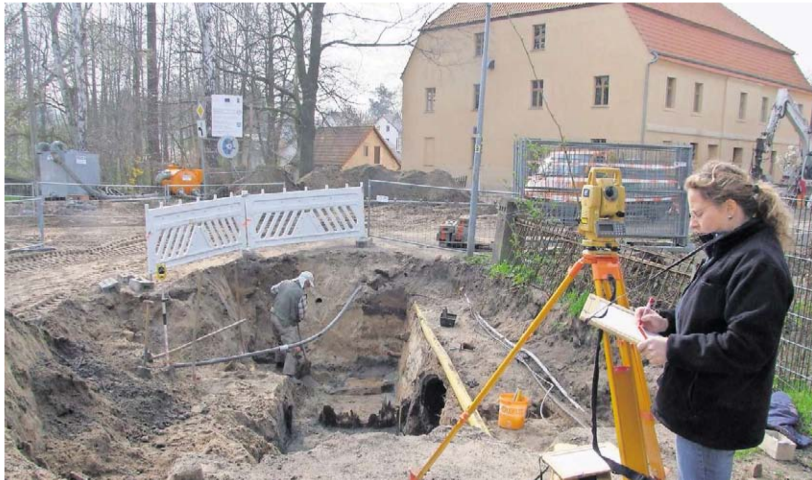
Philine Bach von der BAB GmbH bei Vermessungsarbeiten am historischen Durchlass in der Kastanienallee.
