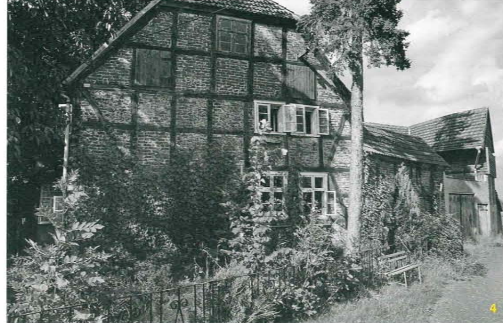
4 Straßenseite des Objektes
