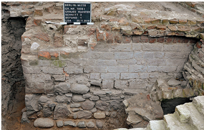
Abb. 133 Nordwestecke des Kreuzgangs, Mauerwerk um 1300
